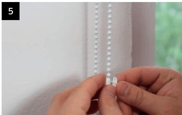
Vyskúšame funkčnosť retiazky a dĺžku rolety jej spustením a vytiahnutím. Roleta pri spustení nesmie narážať do kľučky okna. Ak chceme, môžeme využiť aj brzdy (číslo 5), ale nie je to nutné. Brzda sa zastaví o horný mechanizmus rolety a zabrzdí tak roletu na mieste, kde potrebujeme. Ak ďalej potrebujete, aby roleta išla nižšie, brzdu odstránime, vysunieme roletu do potrebnej dialky a späť nasadíme brzdu na vrchnú časť retiazky. A je hotovo!
